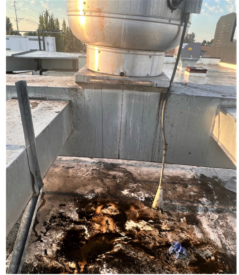
屋顶上的油脂堆积会溢流到你的屋顶排水系统和停车场上，这些油脂污染物会进一步被带到当地的水路中。
