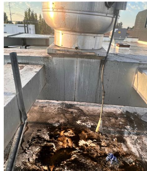
La acumulación de grasa en la azotea puede desbordarse en el desagüe de su techo y en su estacionamiento, donde la contaminación se lleva a las vías fluviales locales.
