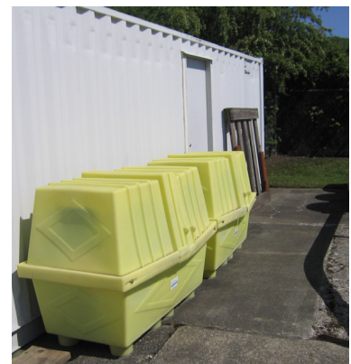
Thùng phụ được cất giữ ngoài trời trong ngăn chứa tràn thùng phụ có mái che
